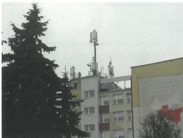
Zał. nr 1: Widok ogólny instalacji radiokomunikacyjnej.
