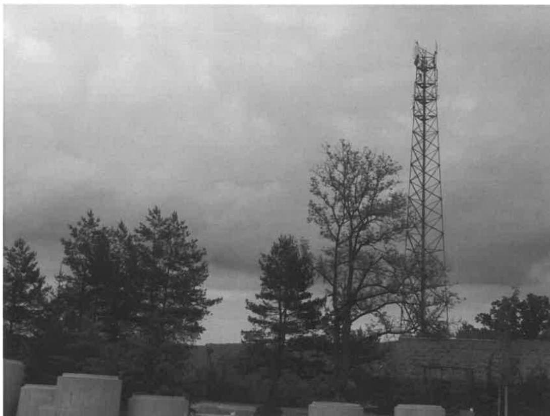
Fot. 1. BT_24632_ŁODZINA – widok wieży antenowej
