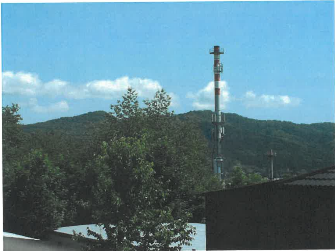
Fot. 1. BT20306_SANOK_WÓJTOSTWO – widok komina z antenami POLKOMTEL
