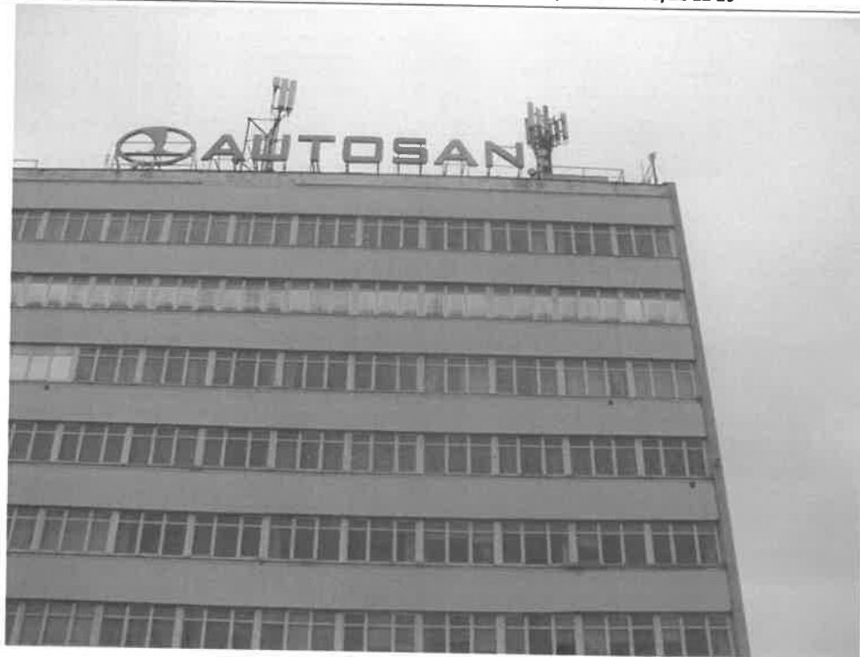
Zał. nr 1: Widok ogólny instalacji radiokomunikacyjnej.
