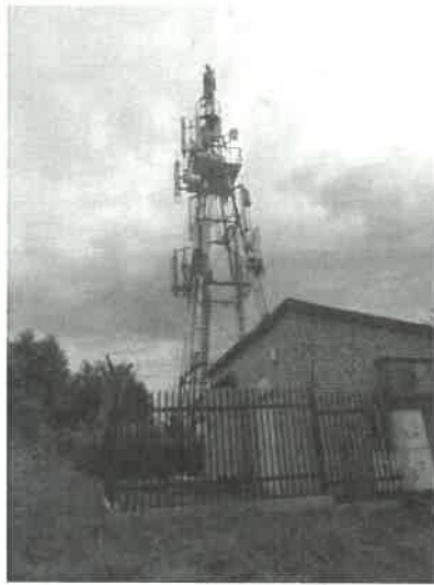
Widok obiektu wraz z zainstalowanym zespołem antenowym
