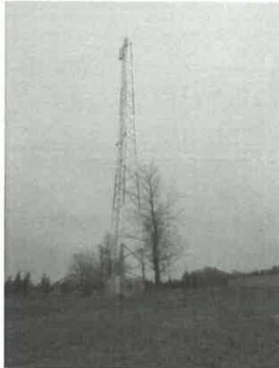
Widok obiektu wraz z zainstalowanym zespołem antenowym
