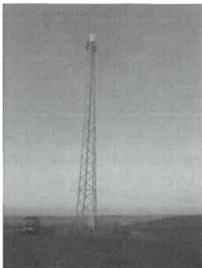
Widok obiektu wraz z zainstalowanym zespołem antenowym
